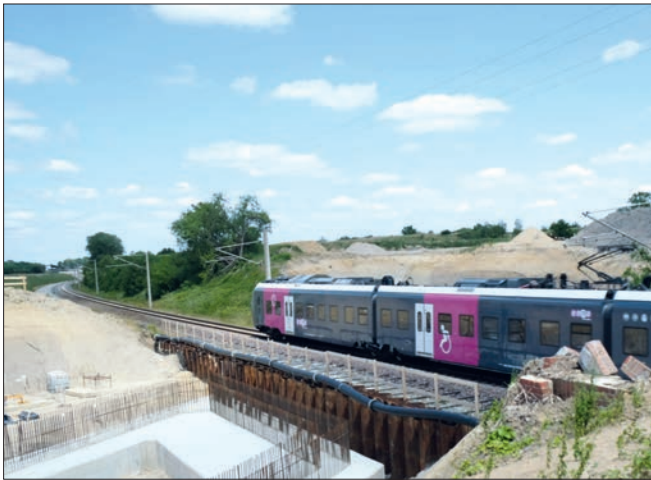
Die Arbeiten zum zweigleisigen Ausbau der Weddeler Schleife haben bereits vor einem Jahr begonnen. Hier ein Foto von Juni 2022.
